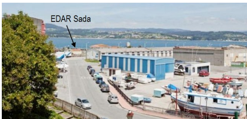
Vial de acceso al Puerto y a la EDAR (Avda. do Porto).
