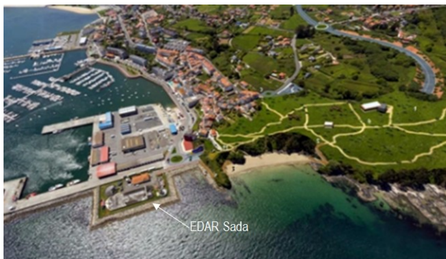
Emplazamiento de la EDAR actual ubicada en puerto de Sada
